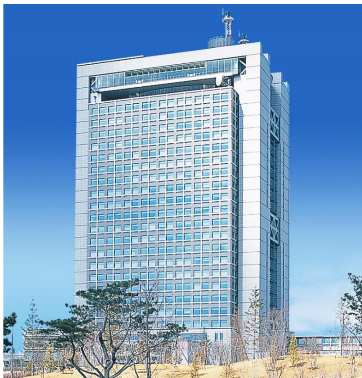
茨城県庁舎空調設備工事
