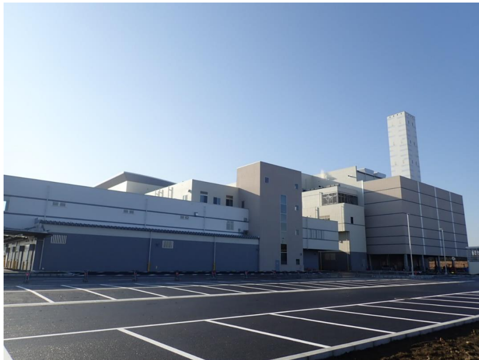
水戸市新清掃工場建設設備工事
